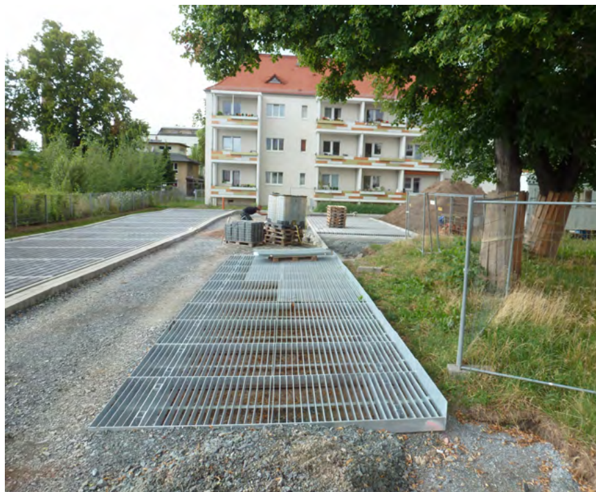
Linde: Wurzelschutz durch Auflast-Verteilung.
