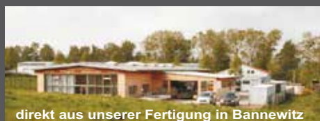
direkt aus unserer Fertigung in Bannewitz
