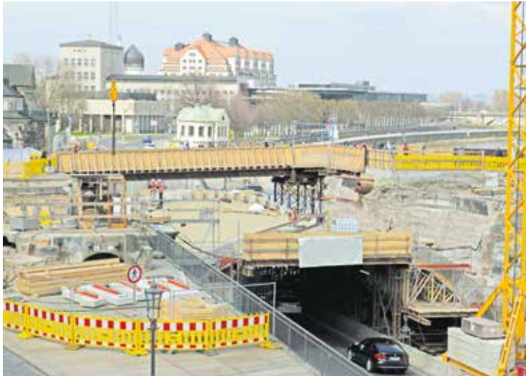
Augustusbrücke. Stand der Bauarbeiten: April 2018
