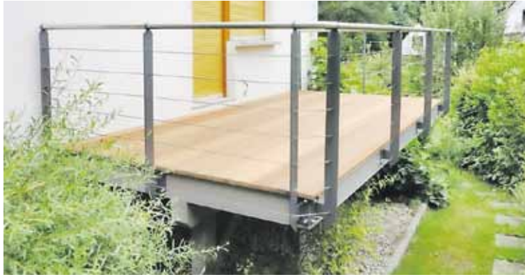
Wer einen Balkon bauen möchte, sollte lieber den Profi fragen. Dieser berät über Material und Bauart. Foto: Holztechnik Lätzsch GmbH
