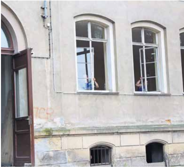
39. Grundschule. An der Schleiermacherstraße 8 in Plauen ist die Gesamtanierung in vollem Gange. Foto: Roland Fröhlich
