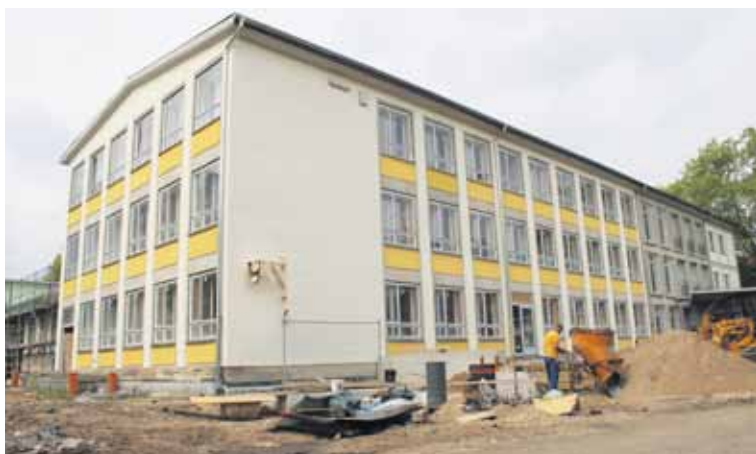
Sanierung der 6. Grundschule.
