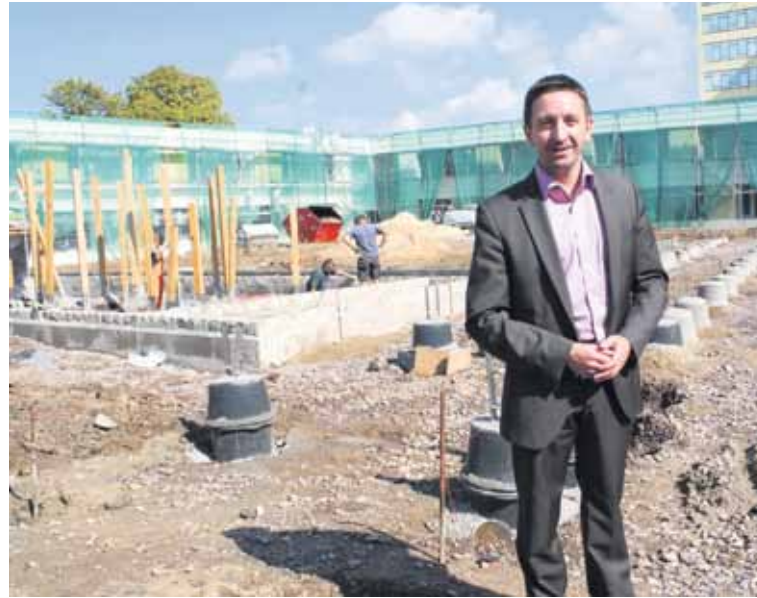
Vor-Ort-Besichtigung. Bürgermeister Martin Seidel auf der Baustelle an der Spenerstraße. Foto: Nora Jantzen
