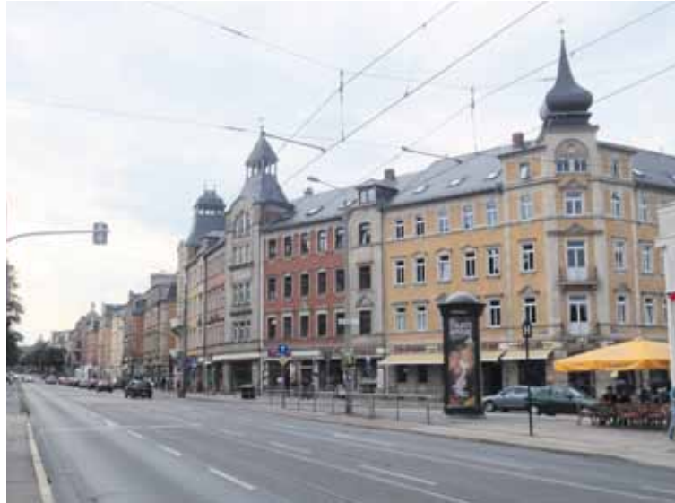
Schöne Häuser säumen den Straßenrand an der Kesselsdorfer Straße Ecke Werner Straße Foto: Sabina Bidder
