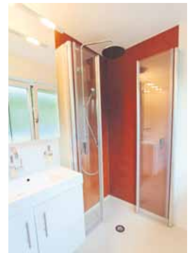
nachher: Boden Mineralwerkstoff fugenlos, Dusche barrierefrei und rutschfest, DK wegfaltbar für großen Einstiegsbereich
