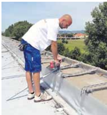
Arbeiten auf dem Dach.
