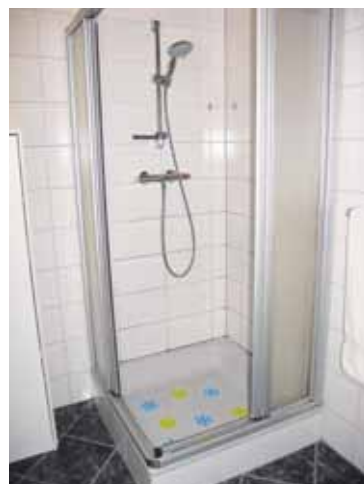
vorher: kleine Dusche, hoher Einstieg, kleiner Einstiegsbereich, Schiebetür
