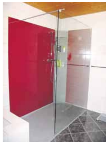
nachher: große, begehbare Dusche, barrierefrei, rutschfest, Paneele, Fixglas
