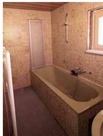
vorher: rutschige Badewanne mit hohem Einstieg, Holzdecke, Fliesenwände
