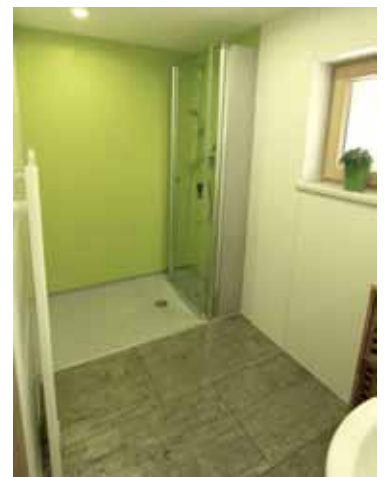
nachher: bodenebene große Dusche, moderner Boden, helle Spanndecke, kaum Fugen
