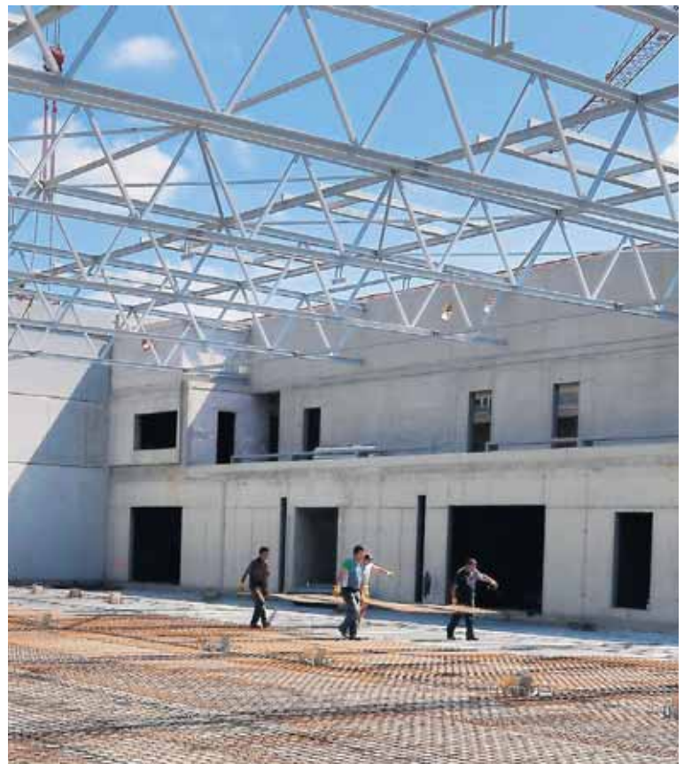
Marie-Curie-Gymnasium. Der Neubau der Dreifeldsporthalle geht voran.
