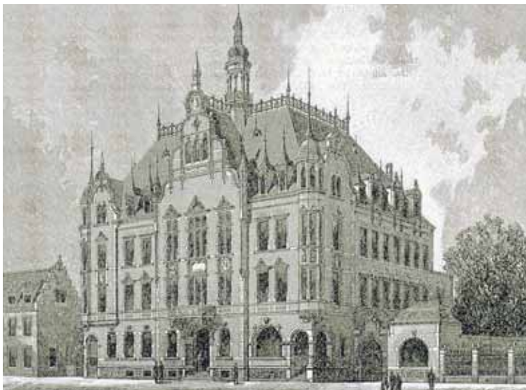
Holzstich Rathaus Pieschen. Das 1891 eingeweihte Rathaus Pieschen, welches vor 20 Jahren denkmalgerecht saniert wurde. Repro: Dirk Schumann
