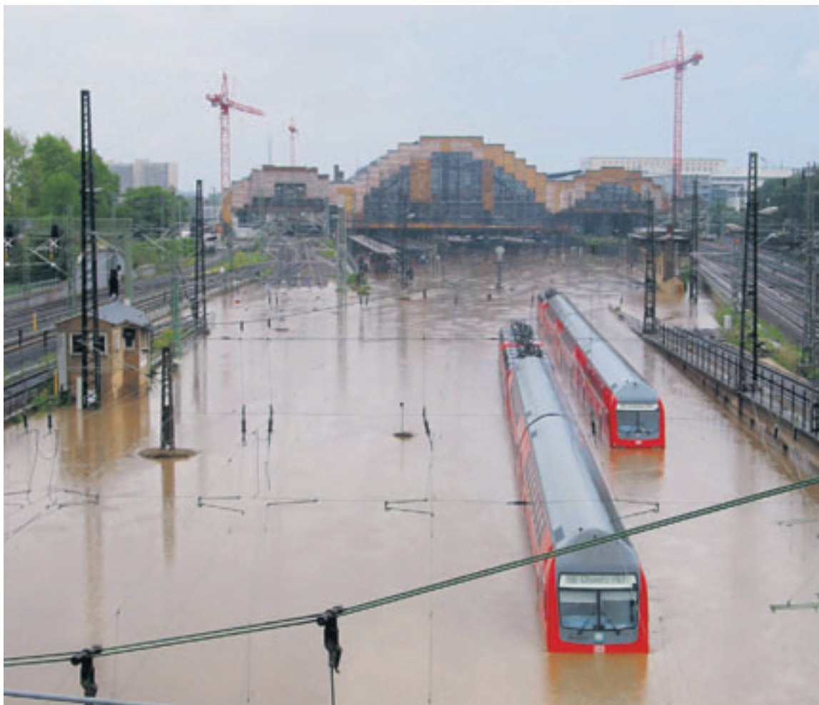
Der Hauptbahnhof in Dresden unter Wasser. Die Weißeritz sorgte im August 2002 für folgenschwere Überschwemmungen. Foto: Landeshauptstadt Dresden
