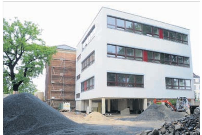
43. Grundschule. Spätestens im Oktober ist diese Schule saniert. Foto: Ulrich Löser
