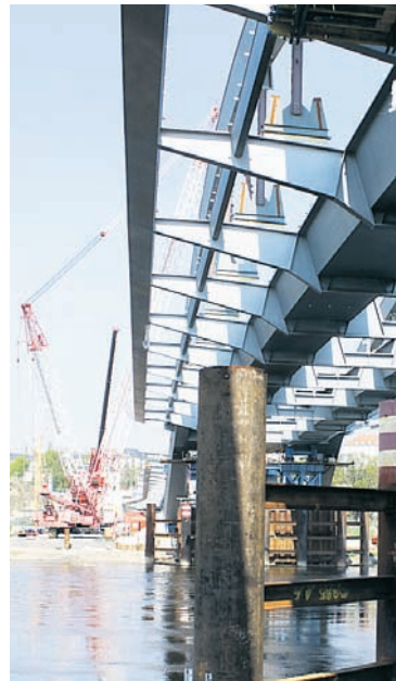
Freistehende Brücke. Der Baufortschritt an der Waldschlößchenbrücke ist sichtbar. Foto: Ulrich Löser
