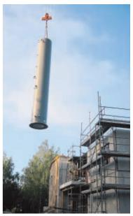
▲ Riesenspeicher kommt. Am 9. Oktober wurde der Pufferspeicher mit einem Baustellenkran in das Gebäude gehoben und aufgestellt. Foto: Hochbauamt
