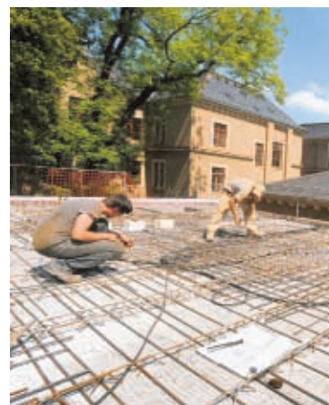
▲ Dachsanierung. Thomas Sperling und Steffen Hoffmann (von links) von der Bergerbau Sanierungs GmbH sind der 63. Grundschule auf der Wägenerstraße aufs Dach gestiegen. Gegenwärtig ziehen sie die Bewehrung für das Dach ein. Bald können die Schülerinnen und Schüler im neuen Erweiterungsbau ihren Schul- und fakultativen Sport ausüben. Foto: Jürgen Männel
