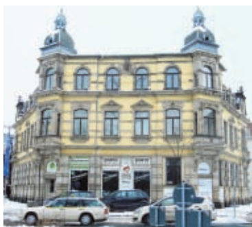
▲ Loschwitzer Straße 50. Foto: Liegenschaftsamt
