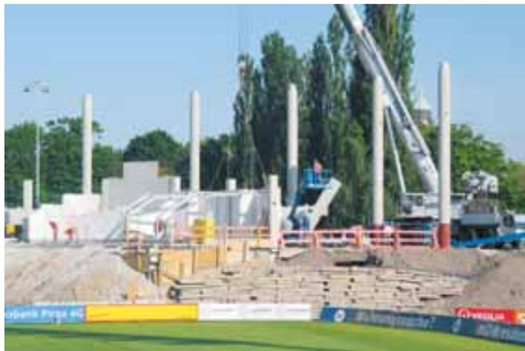
▲ **Stahlbetonträger für Besuchertribüne.** Die Montage erfolgt mit zwei Autokränen. Geplant ist, pro Tag zwei Tribünenbalken
