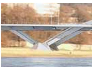
■ Weglassen der Beleuchtungsaufbauten auf der Brücke und Verlagerung der Beleuchtung in die Handläufe der Brücke
