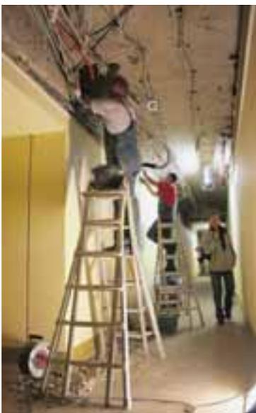
▲ **Kabelsalat.** In den Zwischendecken im Keller des Kulturpalastes verschließen die Bauarbeiter die offenen Kabelführungen. Foto: Bunk
