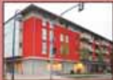
Klotzsche – Am Wasserwerk 1a Infotelefon: 8 89 69 36
