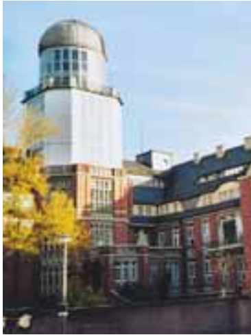
▲ Observatoriumsturm , erbaut 1913, am „Beyer-Bau“ der TU Dresden. Foto: König
