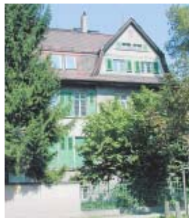
▲ Wiener Straße 71, Dresden-Strehlen
