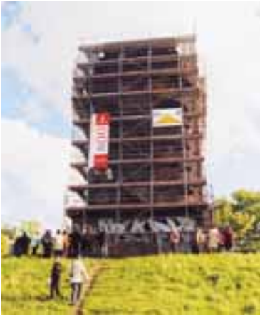
▲ Sanierung. Zum Stadtjubiläum soll die Sanierung der Bismarcksäule abgeschlossen sein. Foto: Knifka
