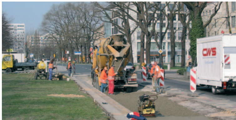
▲ Straßenbau vorm Rathaus. Bis 24. April werden am Dr.-Külz-Ring die Zufahrten von St. Petersburger Straße und Georgplatz bis Schulgasse rekonstruiert. Die Fahrbahnen
