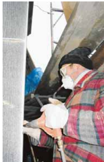
▲ Sanierung. Arbeiten an der Fassade des Rathausturmes. Foto: Knifka
