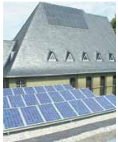
▲ Kirche St. Antonius in Löbtau Fotos: Ingenieurbüro Dr. Scheffler & Partner GmbH
