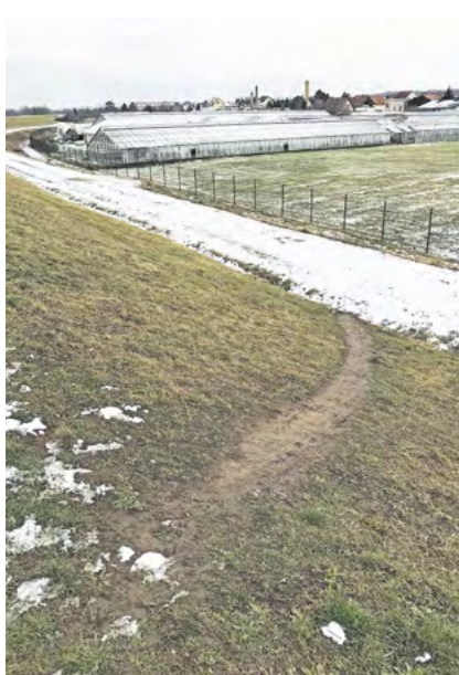
Deich Gohlis. Beschädigte Grasnarbe unterhalb der Deichscharte Windmühlenweg.
