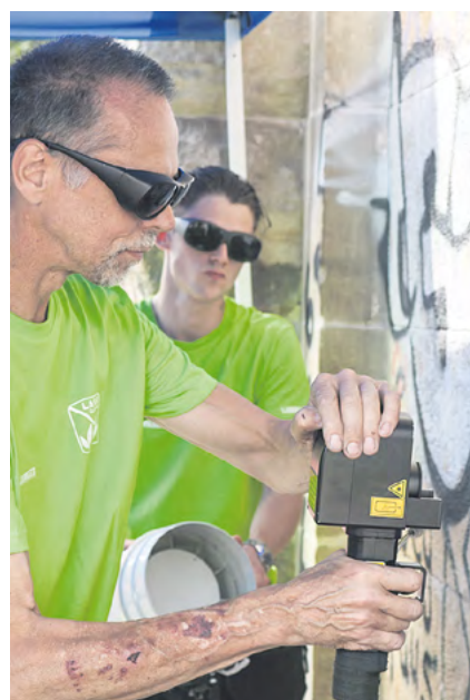
Ralf Urner (vorn) und Fredo Knorr zeigen, wie der Laser in Sekundenschnelle ein Stück des Graffitos entfernt.
