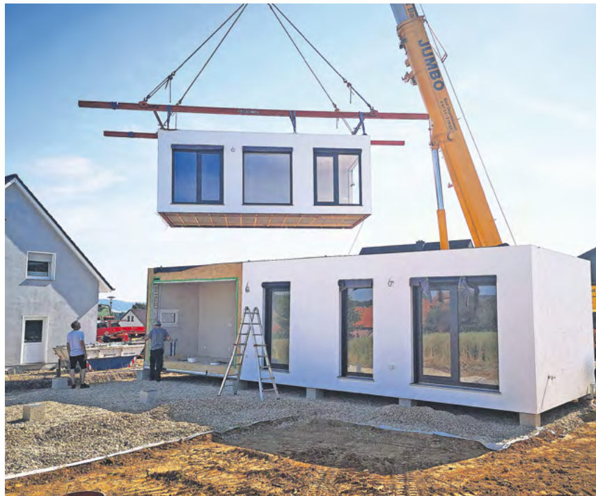
Mit der Modulbauweise kann man auch mehrstöckig bauen. Das spart Bauplatz.
