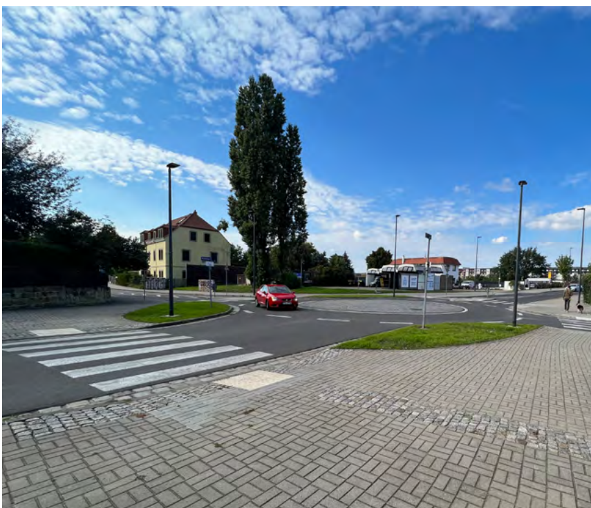
Scharfenberger Straße/Sternstraße. Erweiterung des Kreisverkehrs mit Fußgängerüberwegen. Foto: Straßen- und Tiefbauamt
