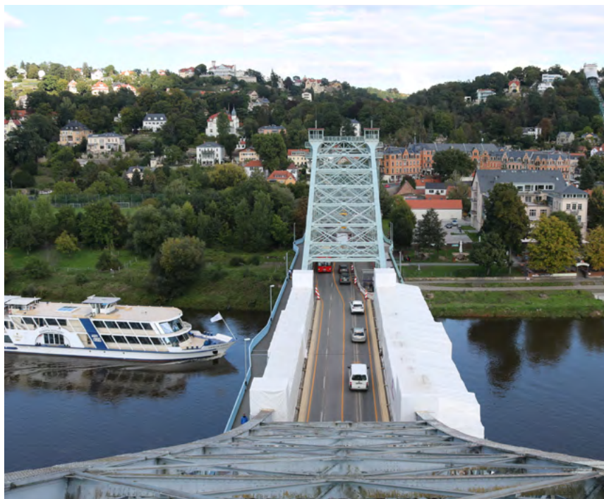
Blaues Wunder von oben. Im September 2022 erhielt die Stadt Dresden einen Förderbescheid in Höhe von rund 13 Millionen Euro für die Sanierung der 130-jährigen Brücke.
