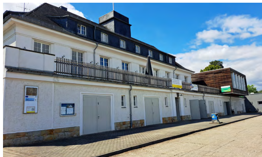
Außenansicht vom Ruderhaus Cotta.
