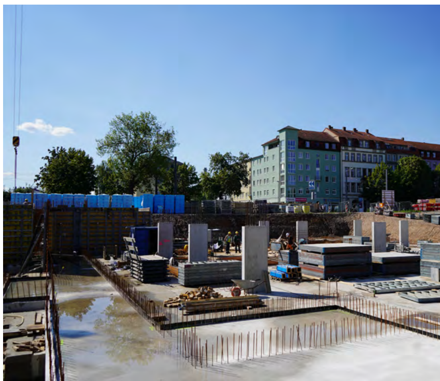
Auf dem Gelände des ehemaligen Kohlebahnhofs an der Freiburger Straße entsteht das neue Berufsschulzentrum für Wirtschaft „Franz Ludwig Gehe“. Foto: Ilja Almendinger
