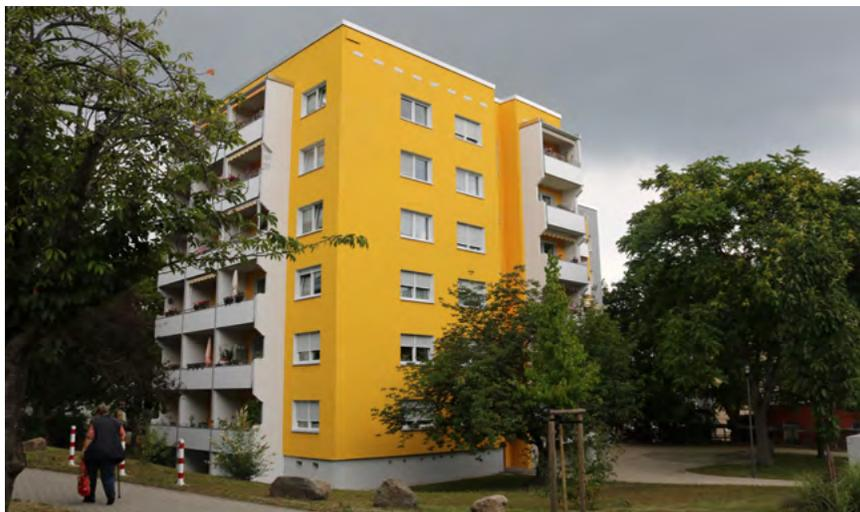
**Hitzeangepasste Sanierung.** Dieses Wohnhaus am Leutewitzer Ring in Gorbitz wurde hitzeangepasst saniert: Außenjalousien, Lüftungsanlagen und ein besonders isolierter Dachaufbau sorgen für angenehmeres Raumklima an Hitzetagen. Foto: Diana Petters
