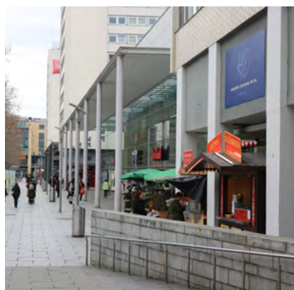
Trüben den Gesamteindruck der Prager Straße: Verkaufsbuden (vorn rechts). Für bestehende Hütten gilt Bestandsschutz.
