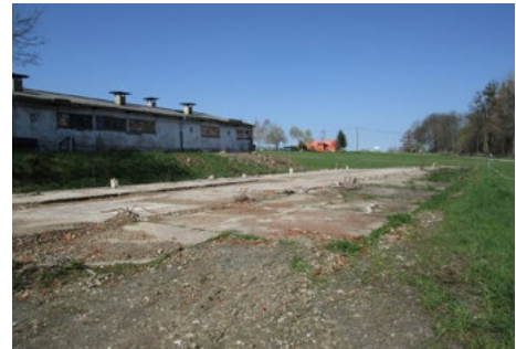
Abbildung 57: Stall 5, oberirdischer Abbruch erfolgt, April 2023 (Quelle: A. Grünwald)
