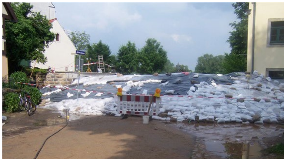
Abbildung 174: Verbau in Altmickten während des Elbe-Hochwassers 2013 (Quelle: Landeshauptstadt Dresden, Umweltamt)
