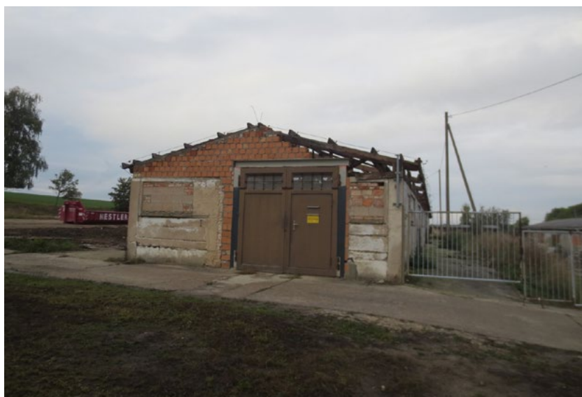
Abbildung 54: Stall 1 kurz vor dem Abriss, Oktober 2020 (Quelle: A. Grünwald)
