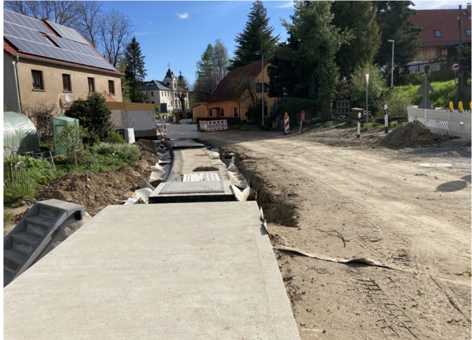
Abbildung 170: Umfluter Schullwitz in der Bauphase (Quelle: Landeshauptstadt Dresden; Umweltamt)
