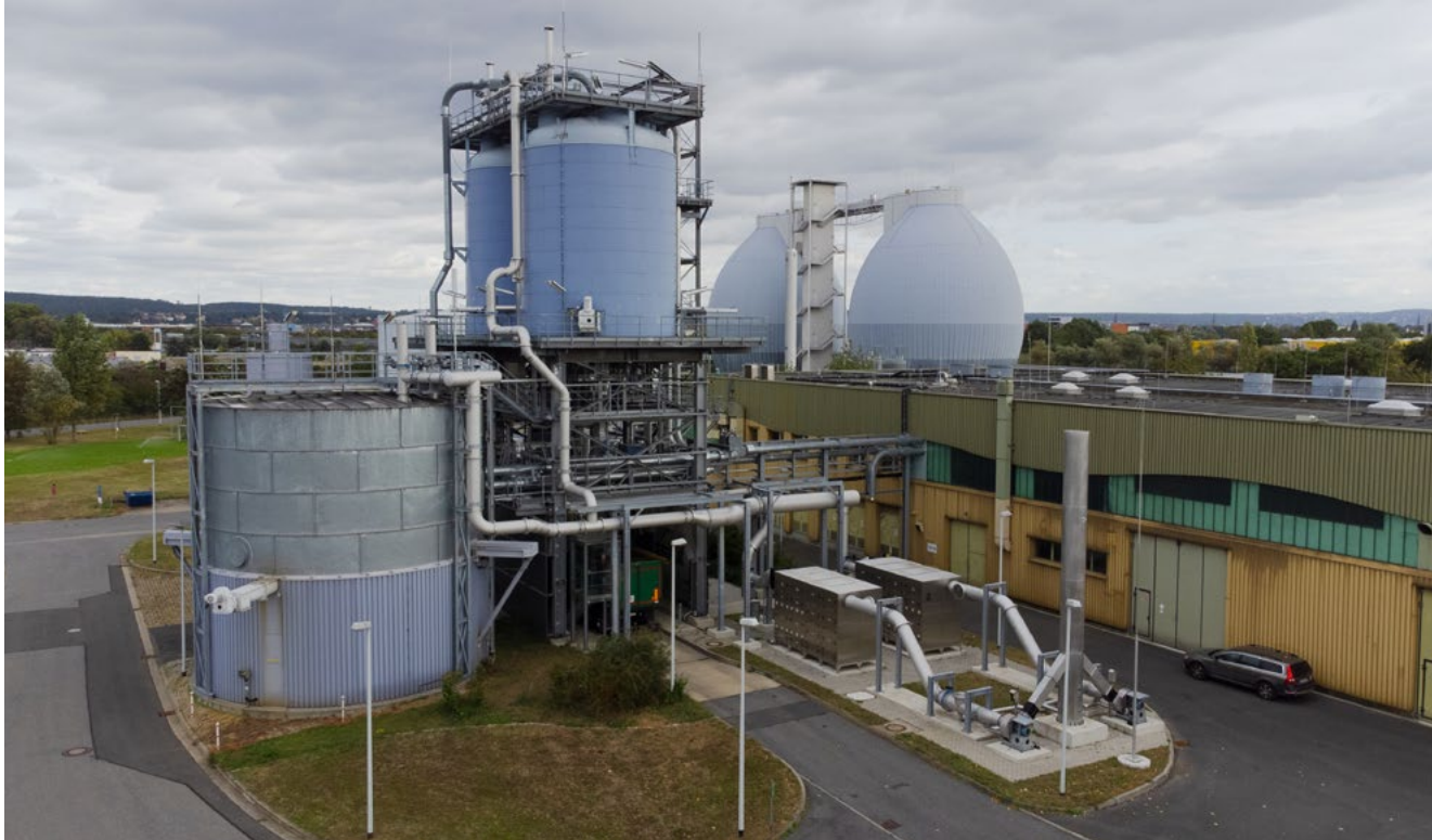
Abbildung 162: Klärschlammverladung, im Vordergrund die Kassetten mit der Abluftbehandlung (Quelle: Die Stadtentwässerung Dresden GmbH)
