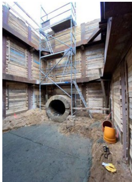
Abbildung 164: Gewaltige Abmessung 2800 x 2700 - jedes der Kunststoff-Elemente hat ein Gewicht von 500 Kilogramm (Quelle: Die Stadtentwässerung Dresden GmbH)
