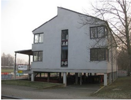
Abbildung 175: Bauvorsorge am Sportvereinshaus Salzburger Straße (Quelle: Landeshauptstadt Dresden, Umweltamt)
