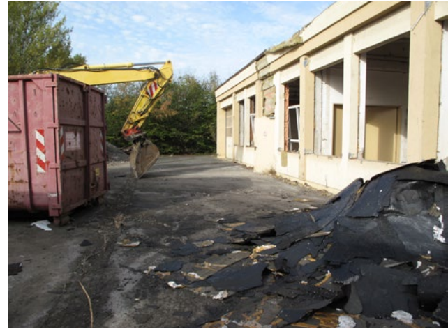
Abbildung 61: Ehemalige Behindertenwerkstätten: Entkernung, Separierung der Baustoffe (September 2019) (Quelle: Landeshauptstadt Dresden, Umweltamt)
