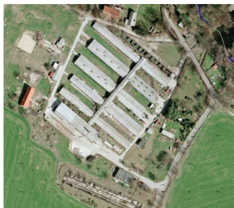
Abbildung 52: Gesamtanlage vor Beginn des Abrisses 2005 (Quelle: Orthophoto, Befliegung vom 15.04.2004)
