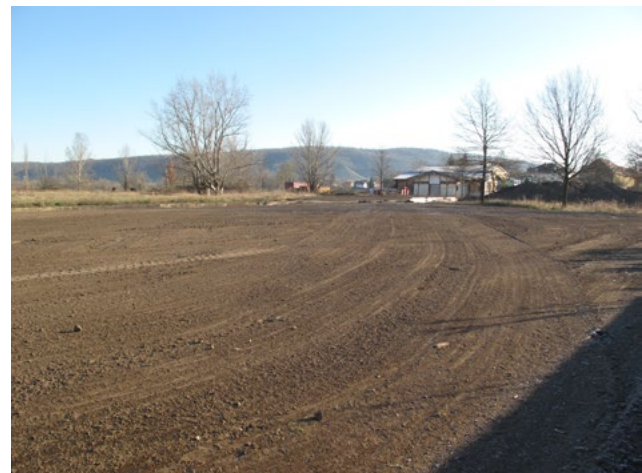
Abbildung 63: Im Vordergrund (südlich Trieske-Kiessee): Fertigstellung Feinplanum für Wieseneinsaat; im Hintergrund restlicher Gebäudebestand der Werkstätten (April 2020) (Quelle: Landeshauptstadt Dresden, Umweltamt)
