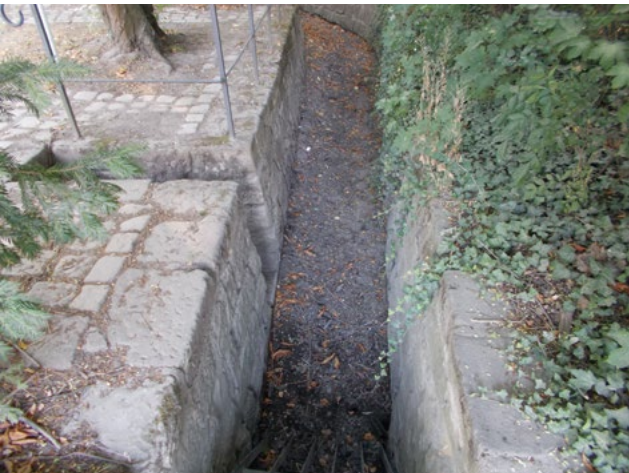
Abbildung 135: Ausgetrockneter Unterlauf des Kaitzbaches, 10. August 2022 (Quelle: Landeshauptstadt Dresden, Umweltamt, Neumann)
