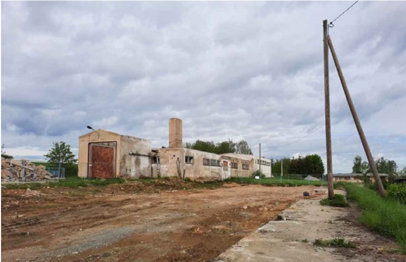
Abbildung 55: Stall 1 kurz nach dem Abriss, Blick auf die bereits im Abriss befindliche Traktorenhalle mit Futtermittellager und Heizhaus, Mai 2021 (Quelle: A. Grünwald)
