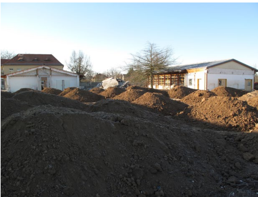
Abbildung 64: Weiterer abschnittsweiser Rückbau der ehemaligen Behindertenwerkstätten (April 2020) (Quelle: Landeshauptstadt Dresden, Umweltamt)
