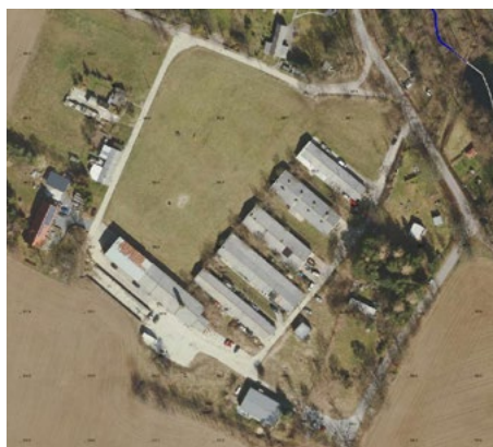
Abbildung 53: bis 2020 noch verbliebene und nun in Abriss befindliche Gebäude (Quelle: Orthophoto, Befliegung vom 30.03.2021)
