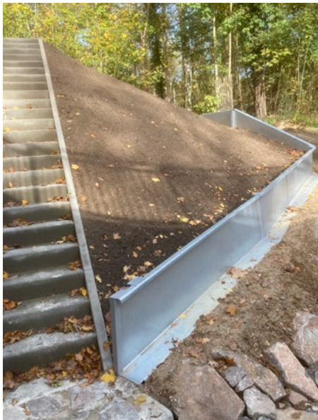
Abbildung 108: Amphibienschutzanlage an der B6 (Quelle: Thomas Hensel)
