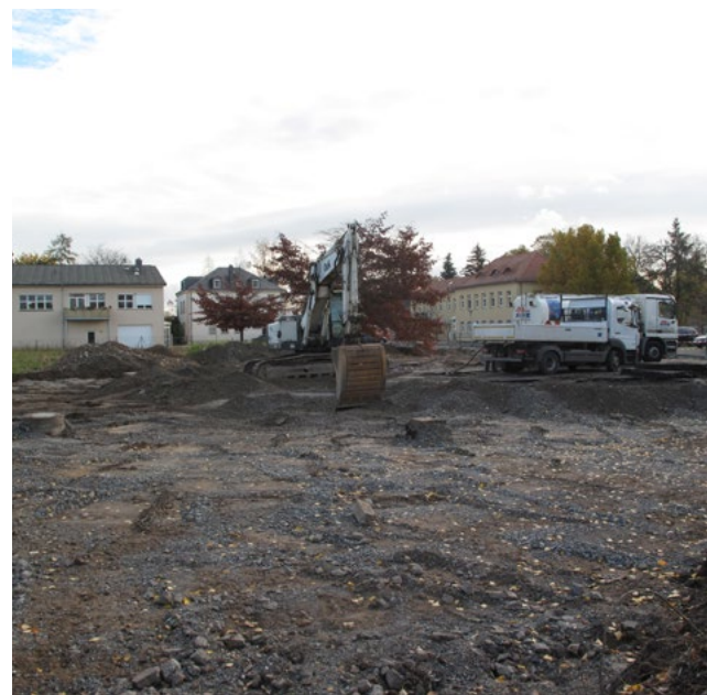
Abbildung 65: Restarbeiten im Bereich des ehemaligen Werkstatthofs (November 2020) (Quelle: Landeshauptstadt Dresden, Umweltamt)
