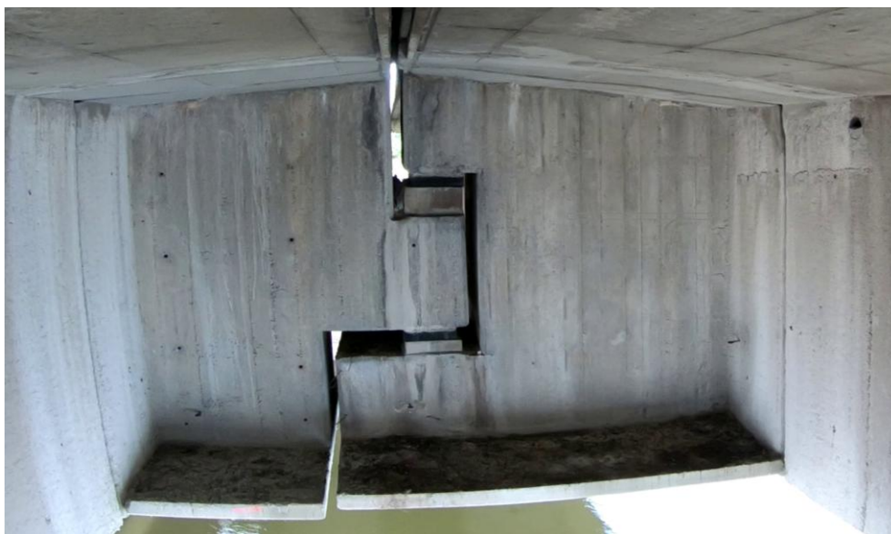
Abbildung 9: Blick auf die Querträgerverbindung zwischen Zug A und Zug B nach dem Einsturz
