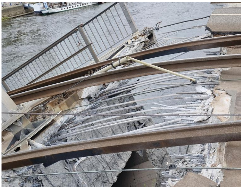
Abbildung 59: Blick auf die Bruchstelle Achse D, Zug C mit ausgezogenen Längseisen \varnothing 22 an der Fahrbahnplattenoberseite
