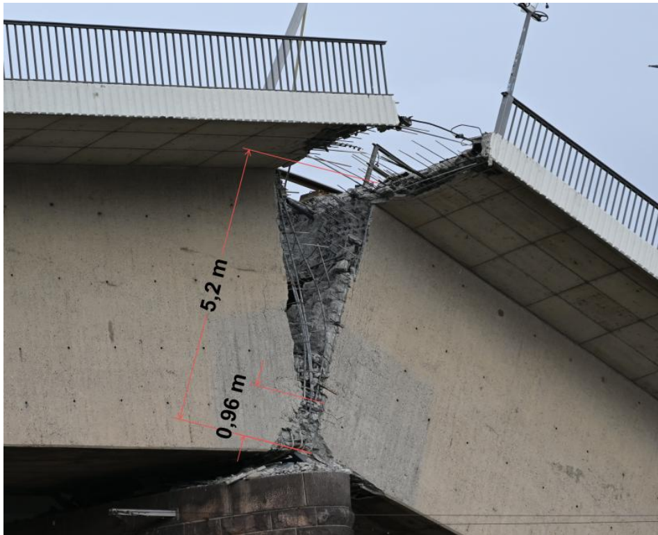
Abbildung 50: Blick auf die Bruchstelle Zug C in Achse D mit Kennzeichnung der vermuteten Druckzonenhöhe
