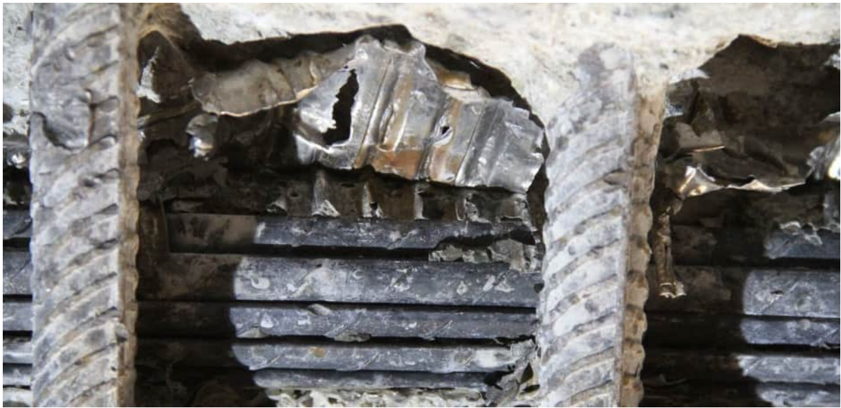
Abbildung 99: Hüllrohrzustand von innen [U14]
