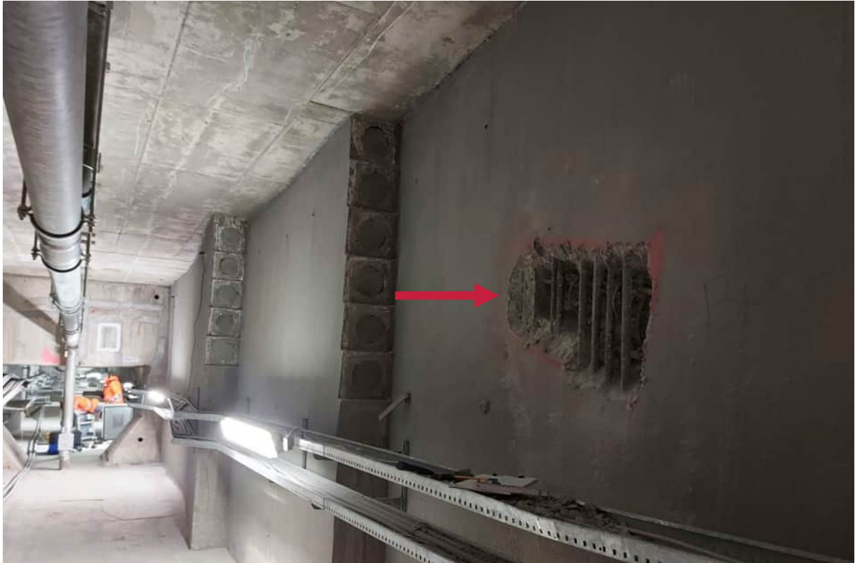
Abbildung 289: Sondierungsöffnung
