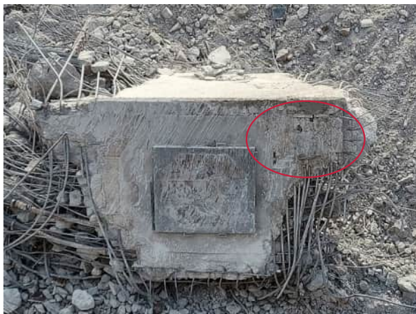
Abbildung 16: Kiesnest am Untergurt des Hohlkastens Zug C direkt am Lager Achse E
