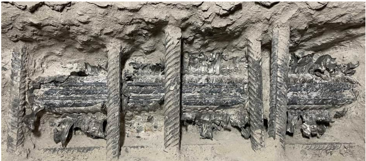
Abbildung 35: Hüllrohrzustand von innen
