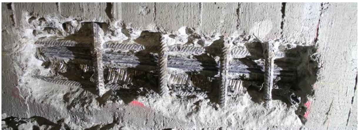
Abbildung 70: Hüllrohrzustand von innen [U14]
