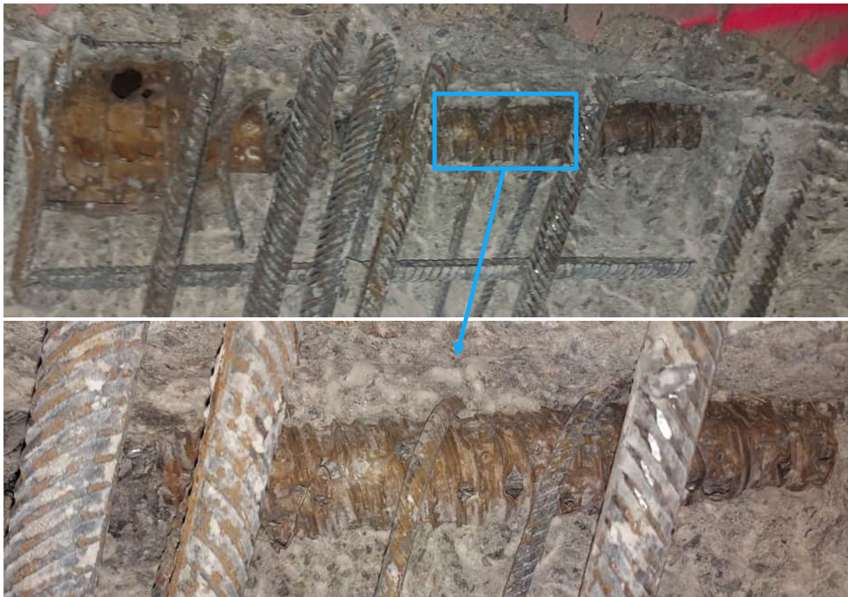
Abbildung 124: Hüllrohrzustand von außen
