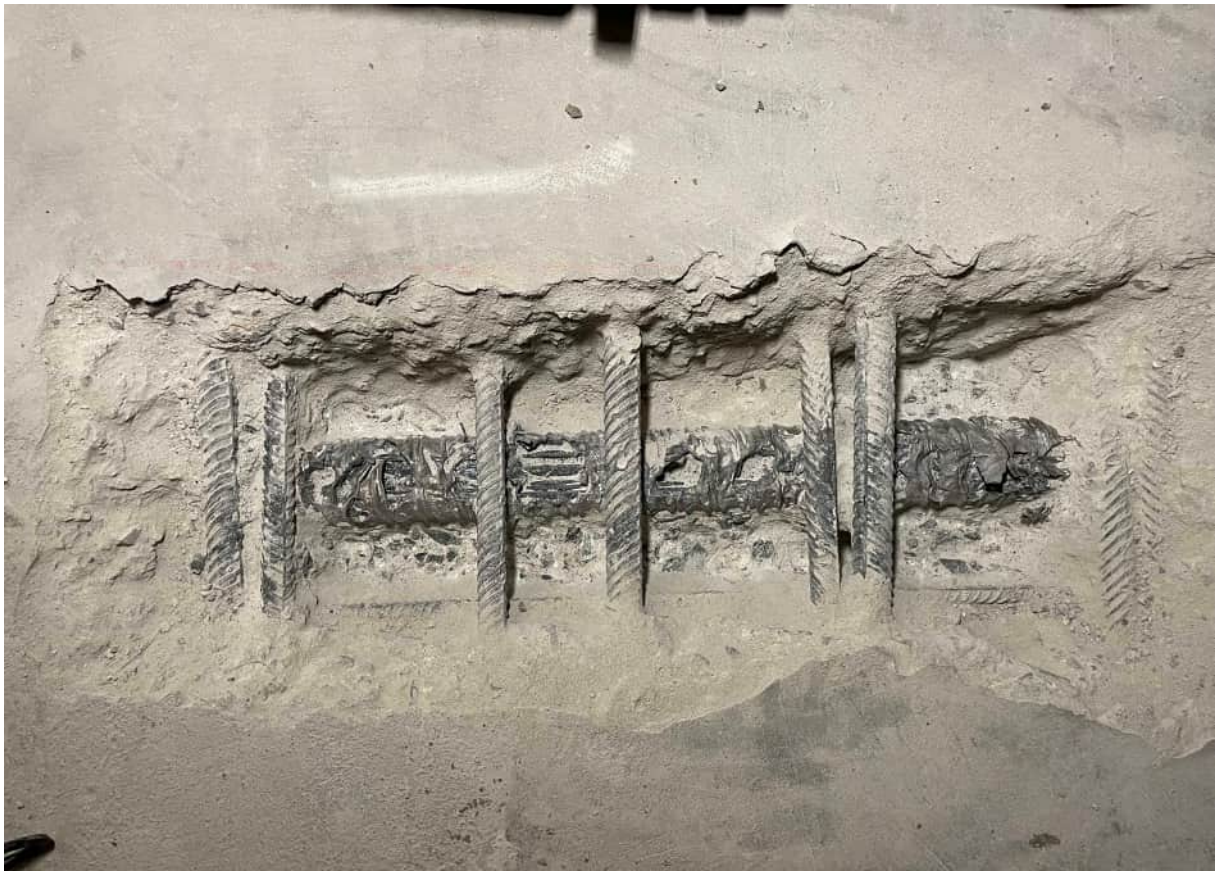
Abbildung 34: Hüllrohrzustand von außen
