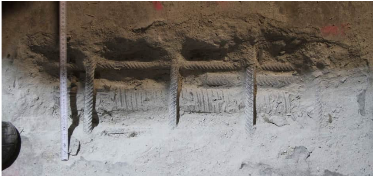
Abbildung 48: Sondierungsöffnung [U14]
