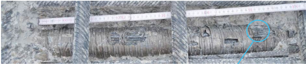
Abbildung 211: Hüllrohrzustand von außen
