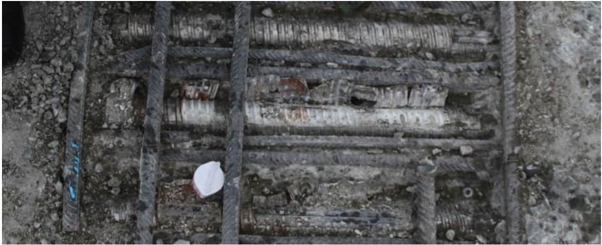
Abbildung 175: Hüllrohrzustand von innen
