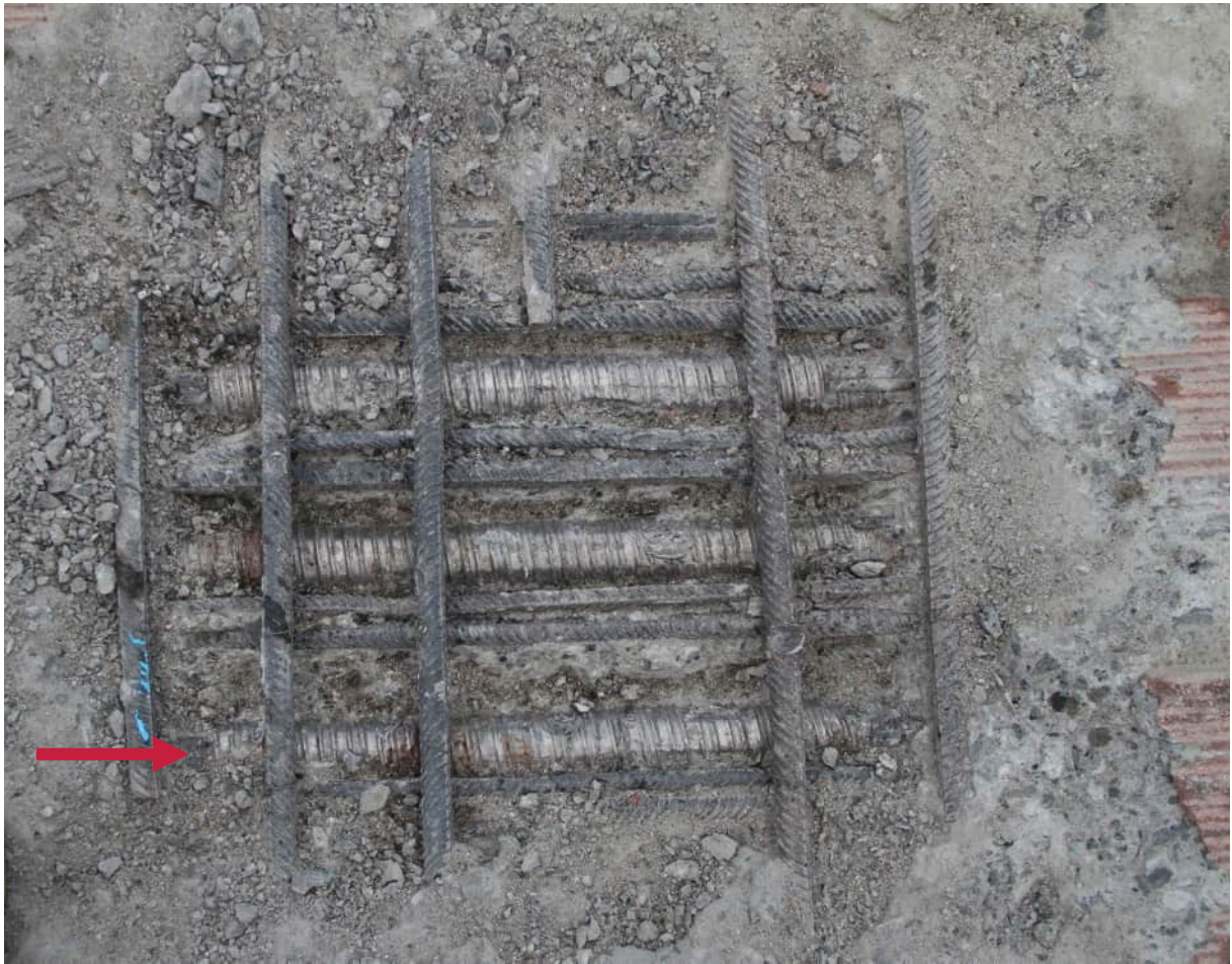
Abbildung 174: Hüllrohrzustand von außen
