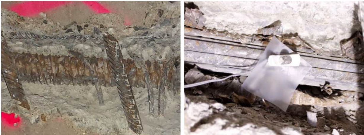
Abbildung 5: Hüllrohr Stegspannglied A-SG-14. Links: Außen stark korrodiert, rechts: Innen ebenfalls korrodiert
