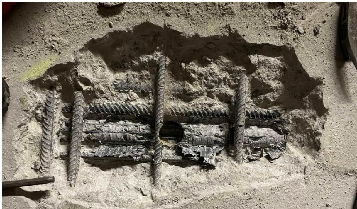
Abbildung 121: Hüllrohrzustand von innen
