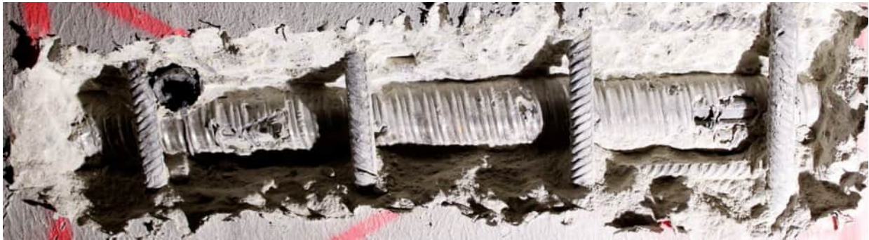
Abbildung 280: Hüllrohrzustand von außen [U14]
