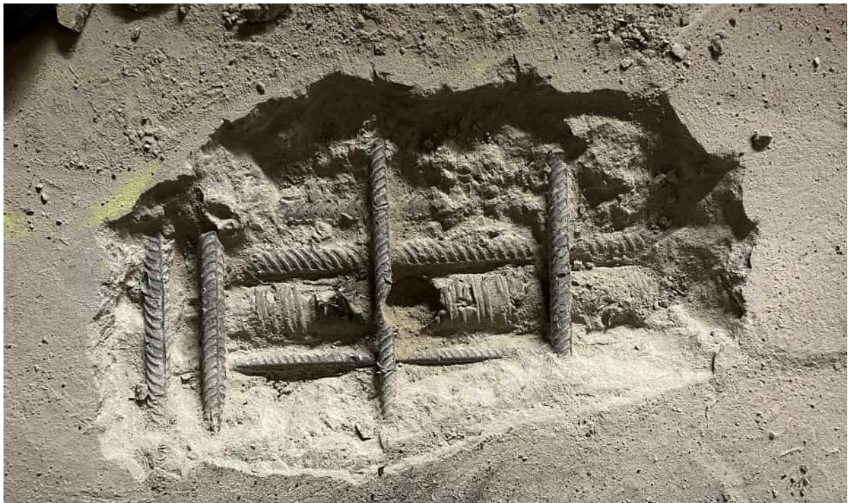
Abbildung 120: Hüllrohrzustand von außen
