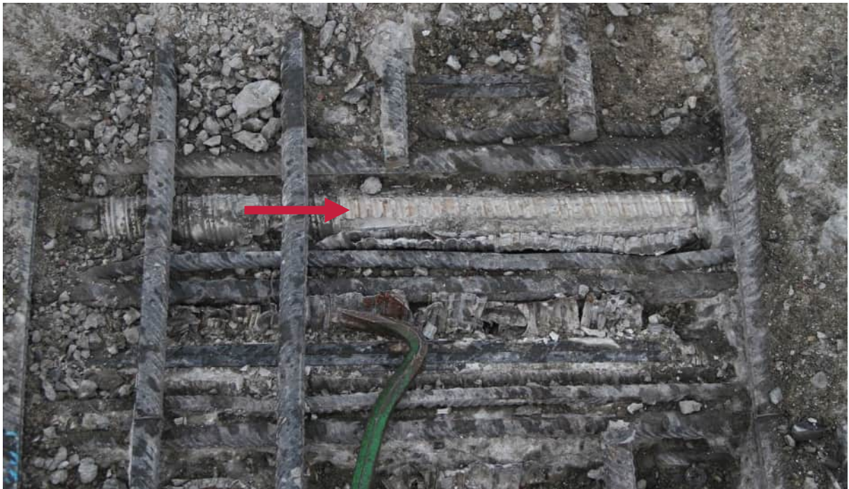
Abbildung 182: Hüllrohrzustand von innen
