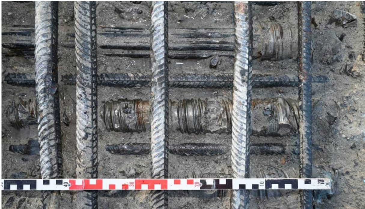
Abbildung 76: Hüllrohrzustand von außen
