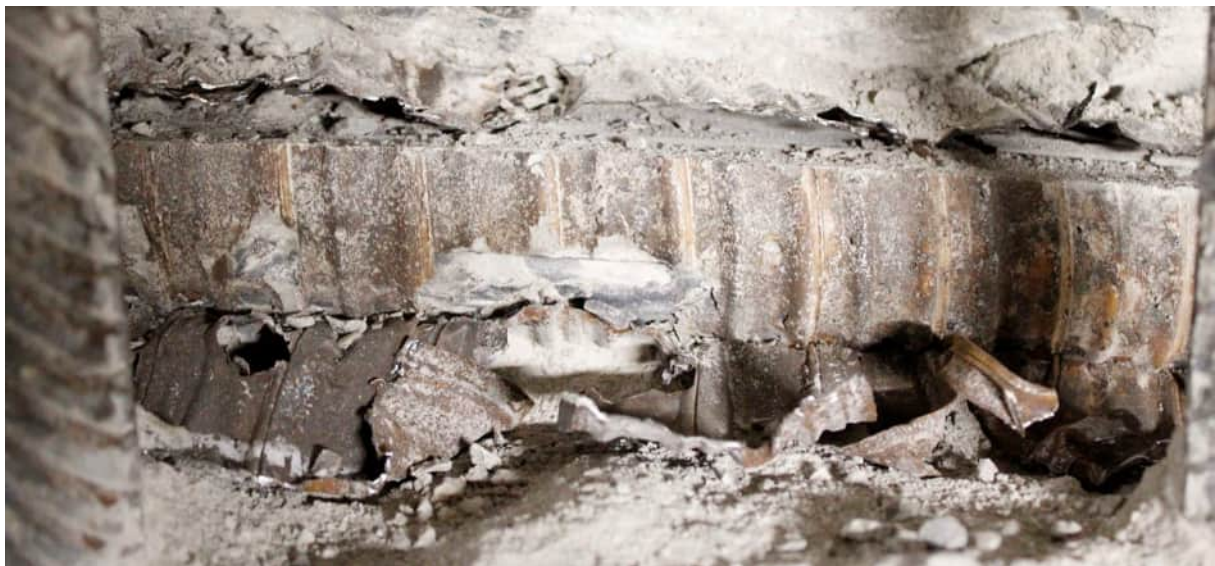
Abbildung 304: Hüllrohrzustand von innen [U14]
