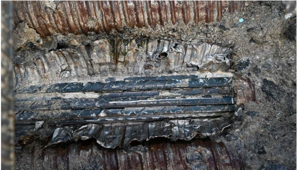
Abbildung 203: Hüllrohrzustand von innen
