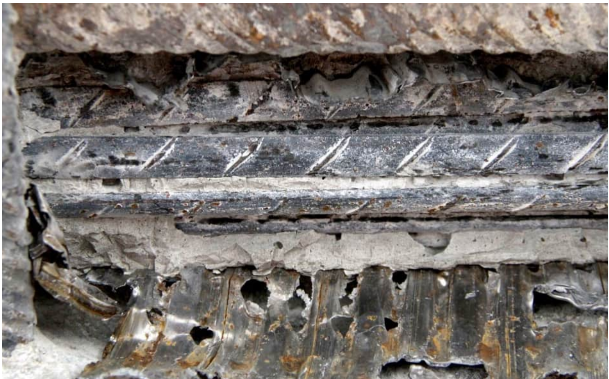
Abbildung 195: Hüllrohrzustand von innen, Verpressmörtel entfernt [U14]
