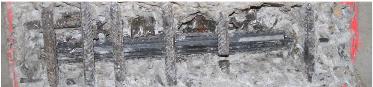
Abbildung 100: Oberfläche der Spanndrähte [U14]
