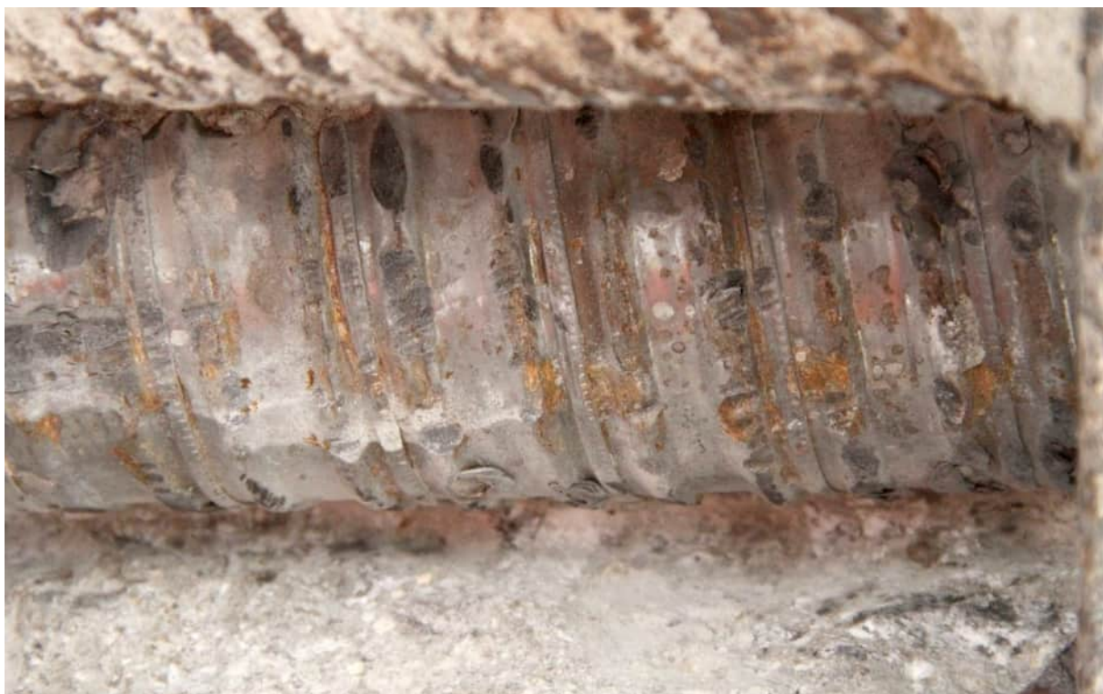
Abbildung 193: Hüllrohrzustand von außen [U14]
