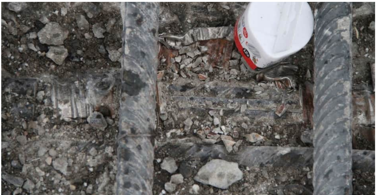
Abbildung 176: Oberfläche der Spanndrähte
