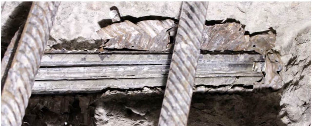
Abbildung 125: Hüllrohrzustand von innen [U14]
