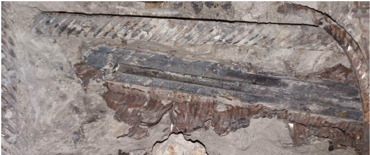
Abbildung 291: Hüllrohrzustand von innen [U14]
