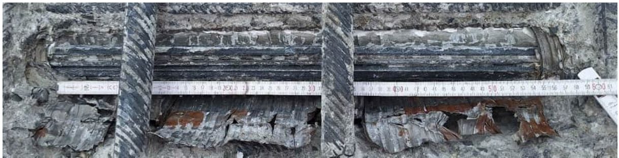
Abbildung 266: Nach Entfernen des Verpressmörtels
