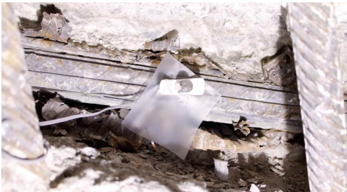
Abbildung 131: Hüllrohrzustand von innen,[U14]
