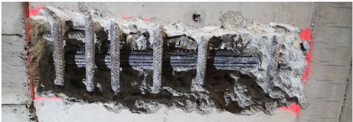
Abbildung 98: Hüllrohrzustand von innen [U14]
