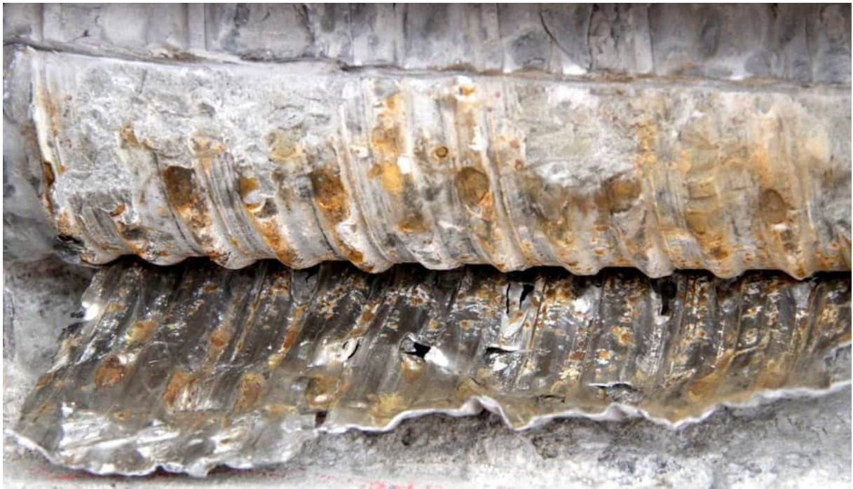
Abbildung 194: Hüllrohrzustand von innen [U14]
