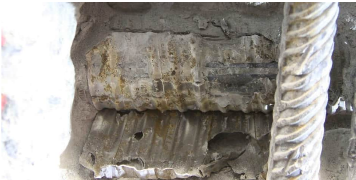
Abbildung 55: Hüllrohrzustand von innen [U14]
