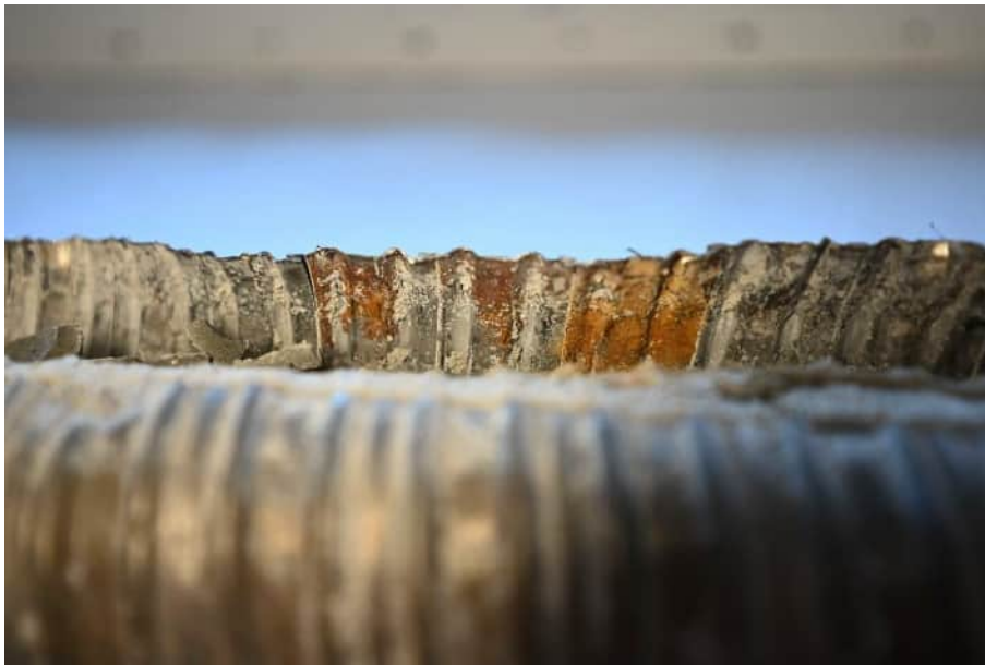
Abbildung 322: Rostspuren an Hüllrohrroberseite (innen)
