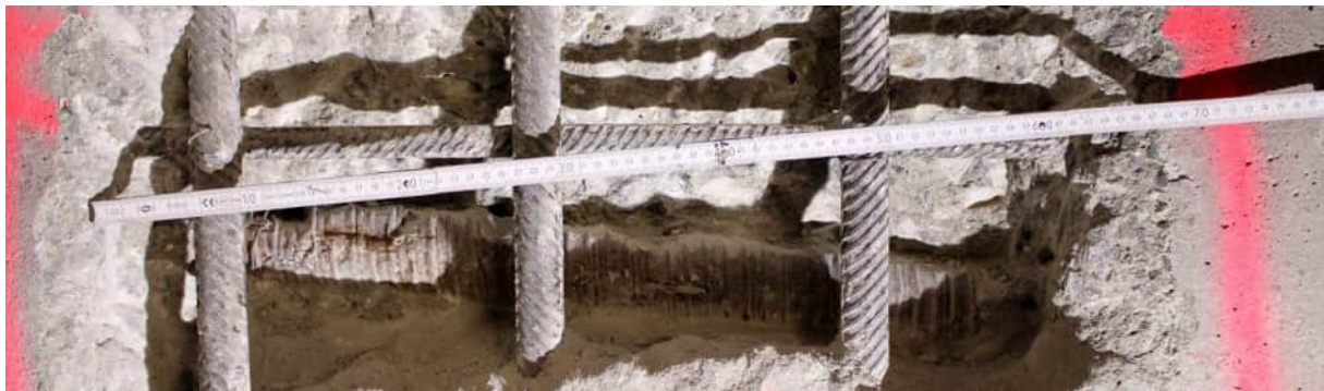
Abbildung 302: Hüllrohrzustand von außen [U14]
