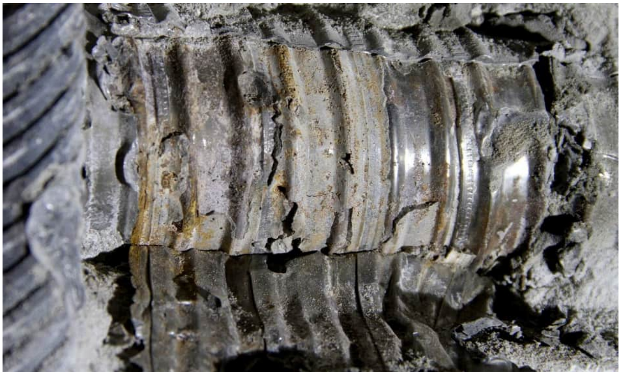
Abbildung 27: Hüllrohrzustand von innen [U14]
