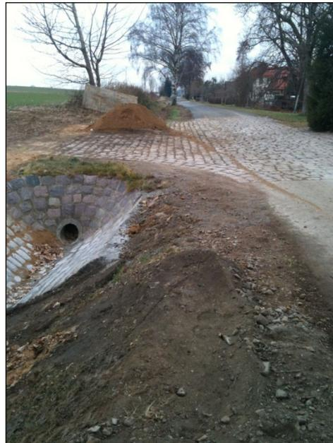
Bild 4: Vor der Maßnahme: Graben am Alten Bahndamm (beräumt) mit Überfahrt
