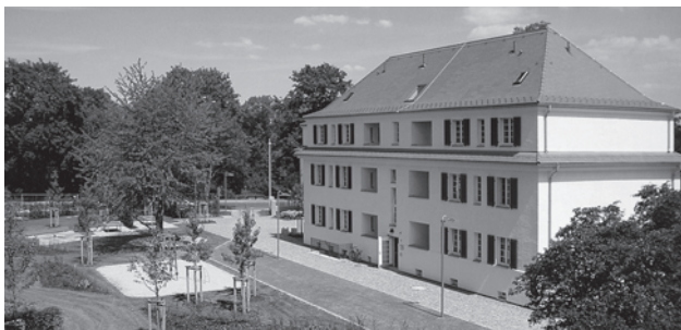
Internat Sportschulzentrum im Ostragehege
