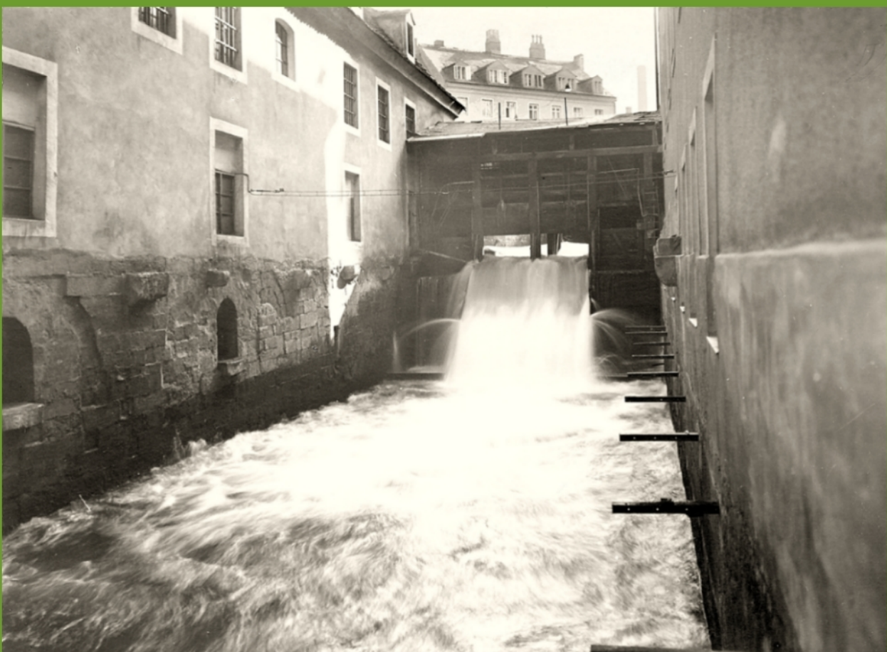
Vier Meter hoher Wasserfall vor der Annenkirche, trieb die Räder der Hofmühle links und der Bäckermühle rechts an, Oktober 1937, Stadtplanungsamt Dresden, Bildstelle
