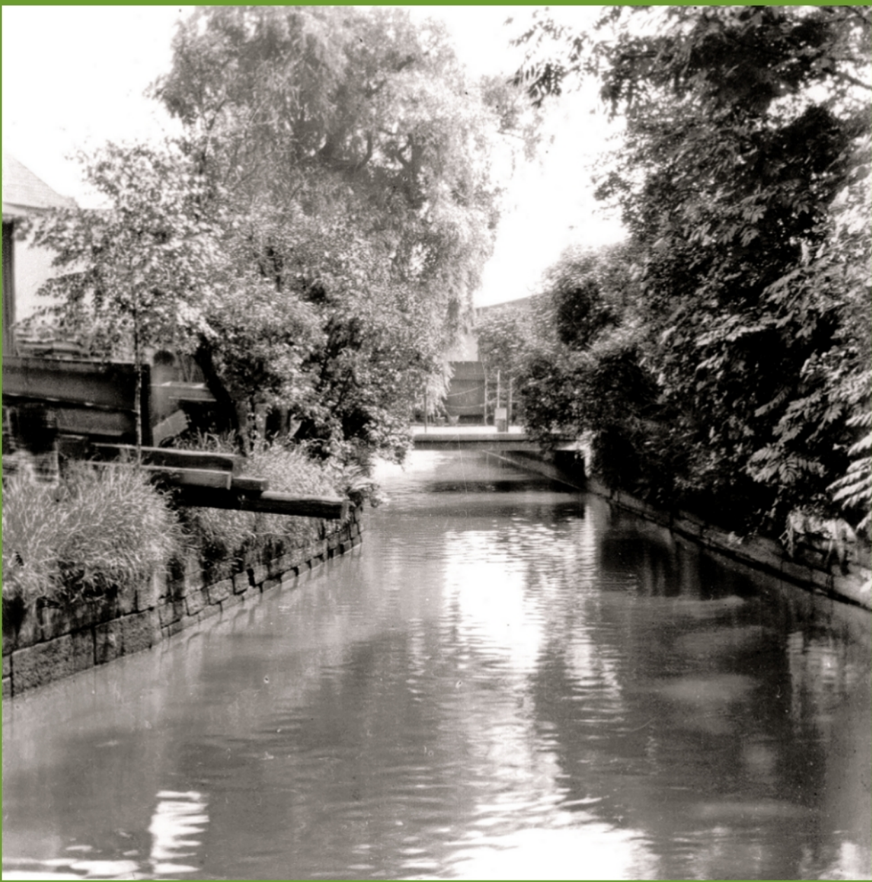
Pulvermühle, Blick vom Einlauf zum Wasserrad flussaufwärts zur Grundstücksgrenze an der ehemaligen Gaststätte „Sorge“, Oktober 1937, Stadtplanungsamt Dresden, Bildstelle
