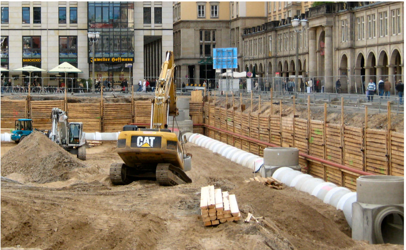
Verlegung Abwasserkanal September 2007 (Foto: Stadtplanungsamt)
