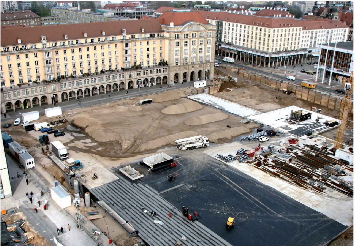
Stand Baumaßnahmen Mai 2008
