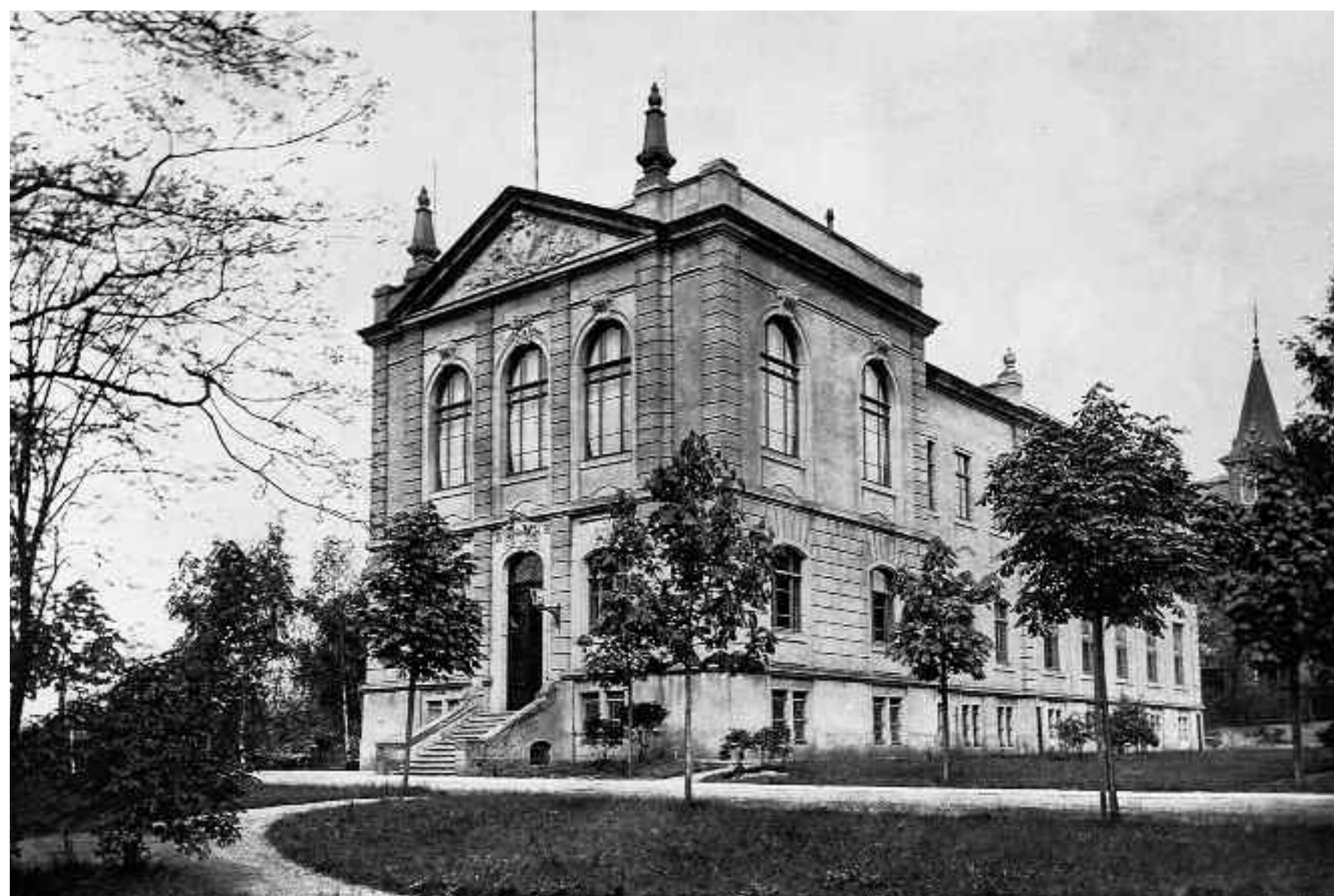
5 Das Gebäude des Sächsischen Kriegsarchivs (ab 1937 Heeresarchiv) wurde 1898 erbaut. Das Stadtarchiv Dresden war von 1946/1947 bis Ende 1999 hier untergebracht.
