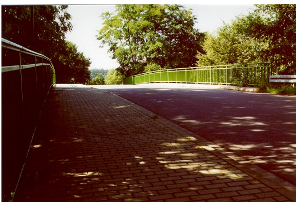
Brücke an der Klotzcher Straße, 1997 erneuert
