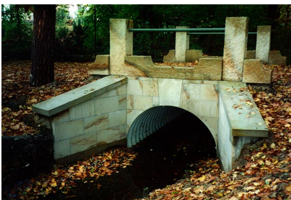
Brücke am Steinweg - Oktober 1996 fertiggestellt
