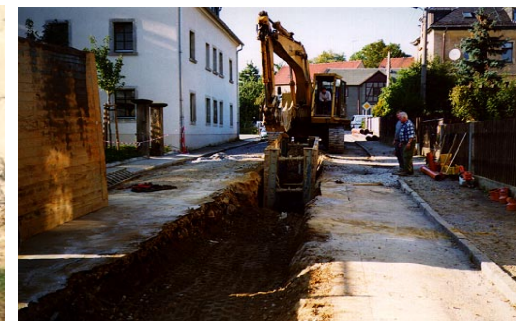
Bruhmstraße: Baumaßnahmen für die Abwasserleitung 1998
