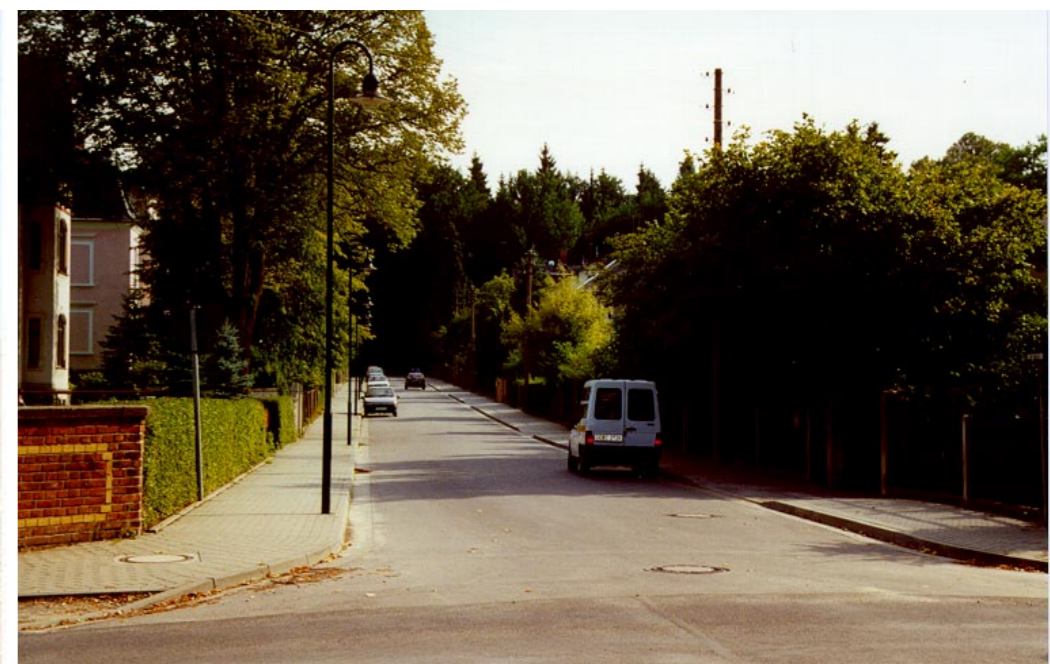
Ein Teil der Bergerstraße wurde 1997 saniert
