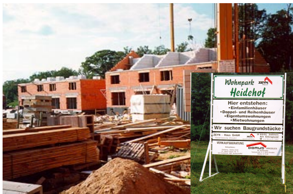
Baustelle im August 1993
