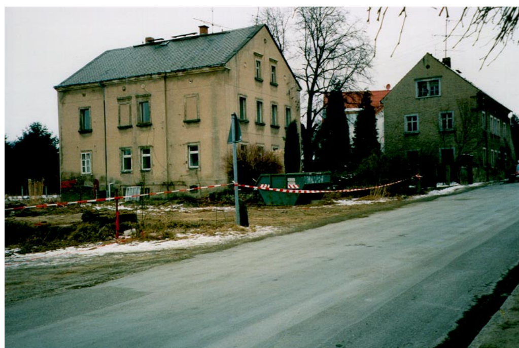
Vor Baubeginn: das ehemalige Bruhm'sche Forstgut Aufnahme: Februar 1996
