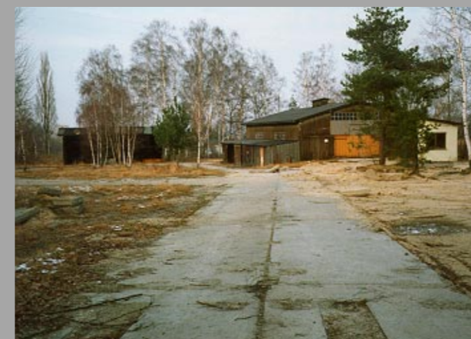
Gelände Dresden Strasse 100 vor Baubeginn Aufnahme: Februar 1994
