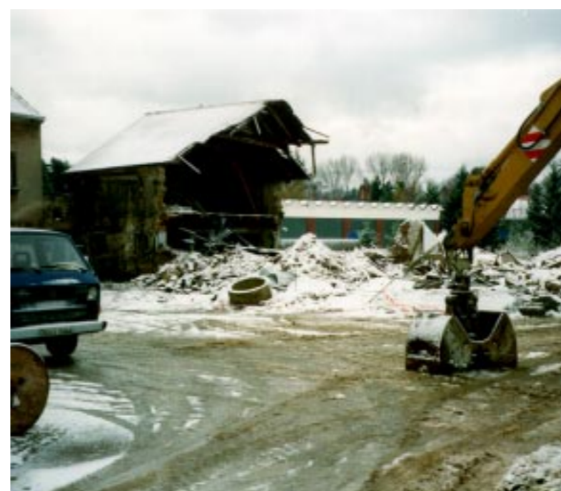
Abriss des Stallgebäudes - Aufnahme: 07.02.1996
