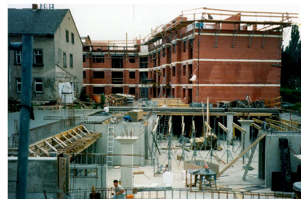
Bauzustand im August 1996
