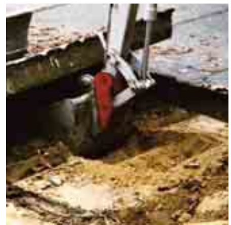
Abb. 2.1: Versickerungsanlage im Bau Abb. 2.1.1: Flächenentsiegelung
