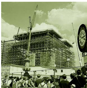
Staveniště chrámu P. Marie
